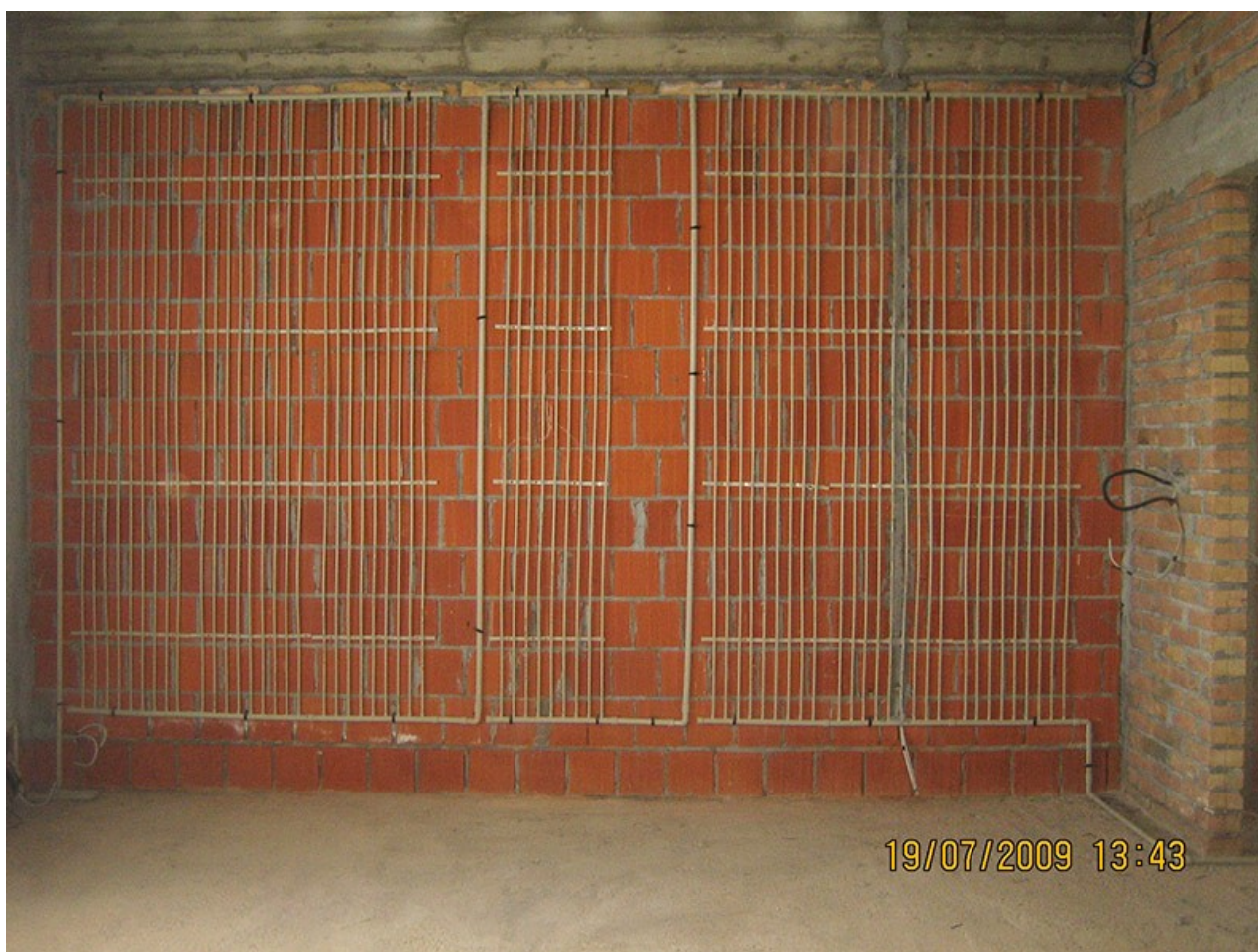
Ugradnja zidnih panela za površinsko grejanje/hlađenje postupkom mokre ugradnje
