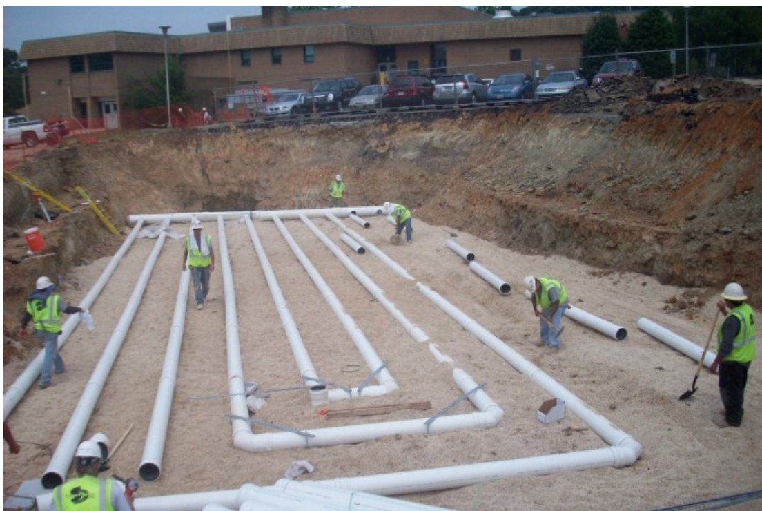
Sistem polietilenskih cevi koje se polažu na dubini od 1,5 do 2 m
