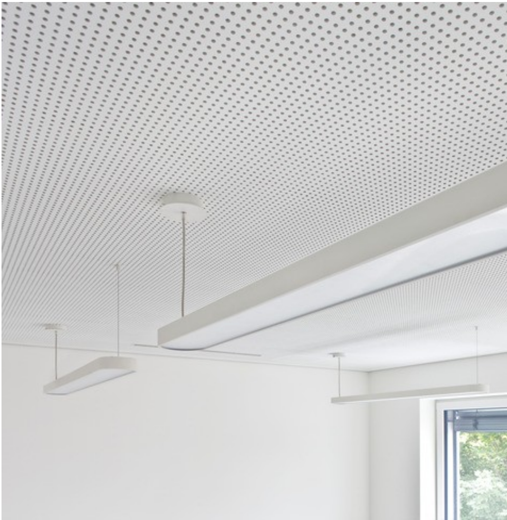
Plafon za grejanje/hlađenje izrađen postupkom suve ugradnje
